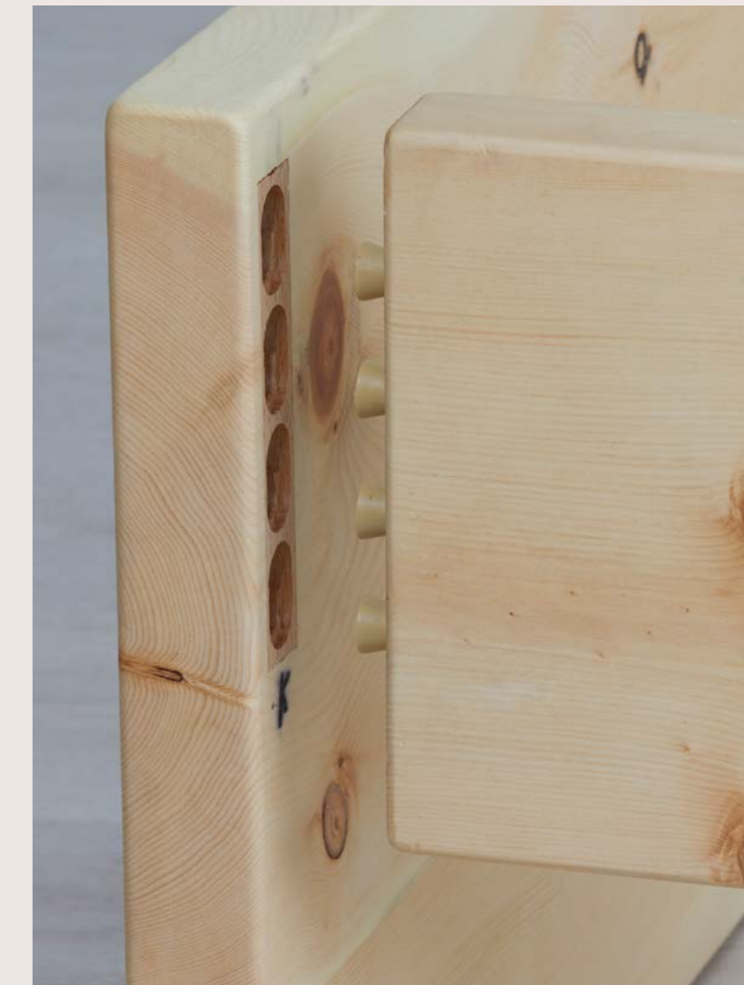
Abbildung: Metallfreie Eckverbindung zum Einhängen, Arve (Zirbenholz)
